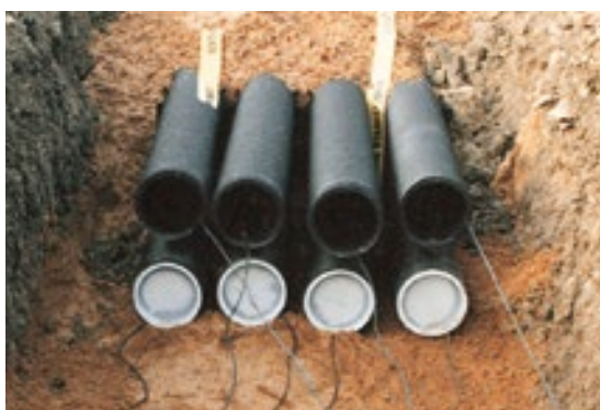
Kabuflex S – vejledende afstandsholdere gør udlægningen sikker og hurtig
