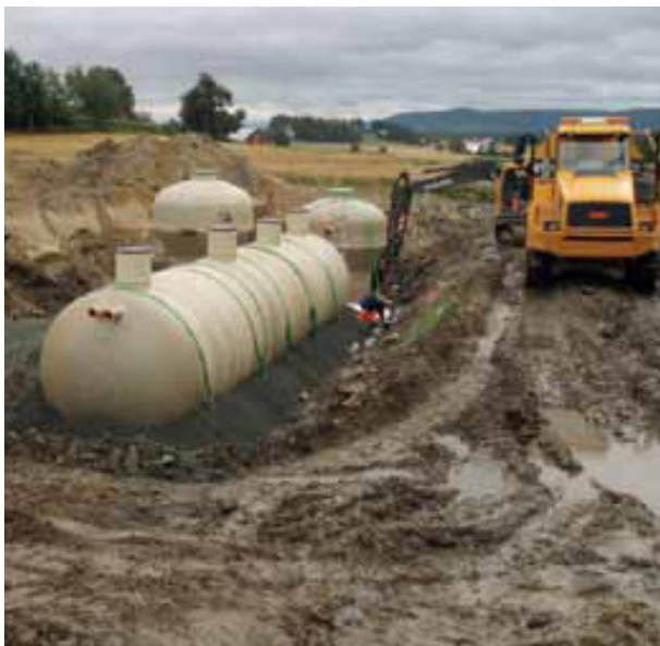
Slamavskiller med infiltrasjon under bygging.
